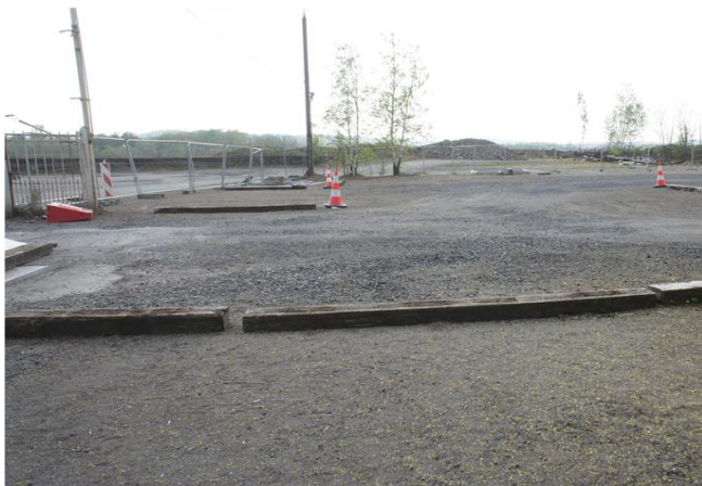
Foto gegen Fließrichtung
