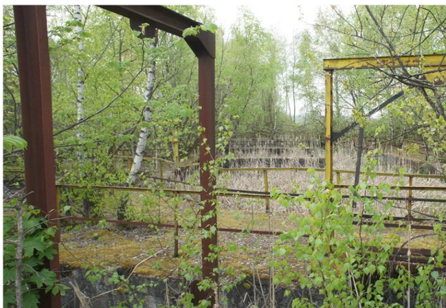
Foto gegen Fließrichtung
