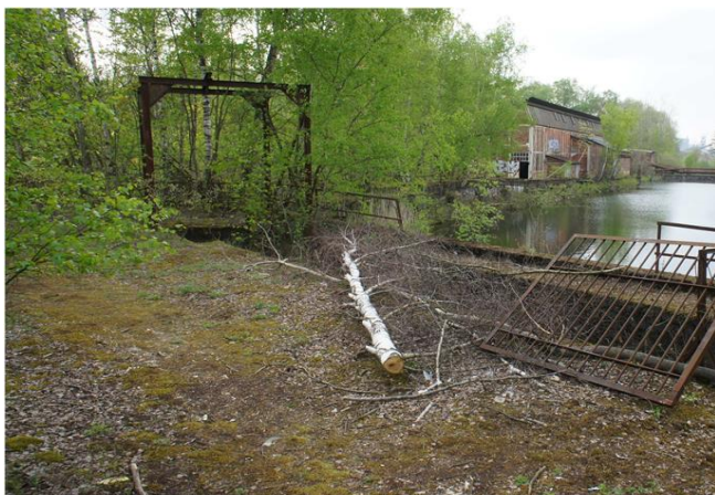
Foto gegen Fließrichtung
