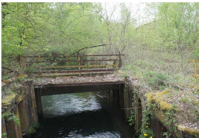
Foto gegen Fließrichtung
