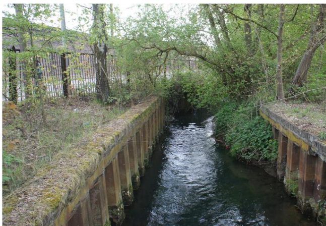
Foto gegen Fließrichtung
