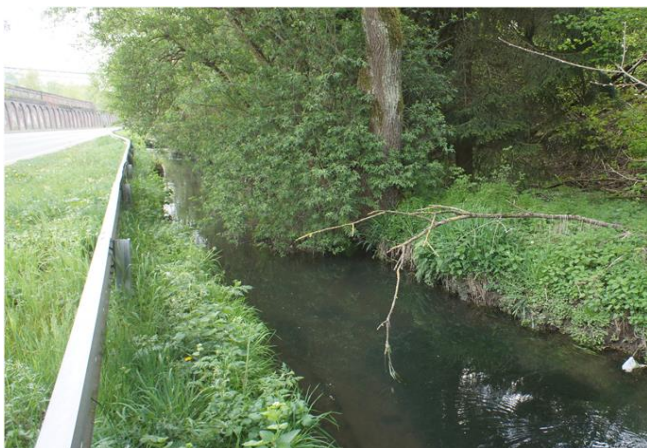
Foto gegen Fließrichtung
