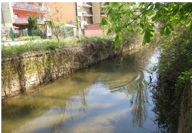
Foto gegen Fließrichtung
