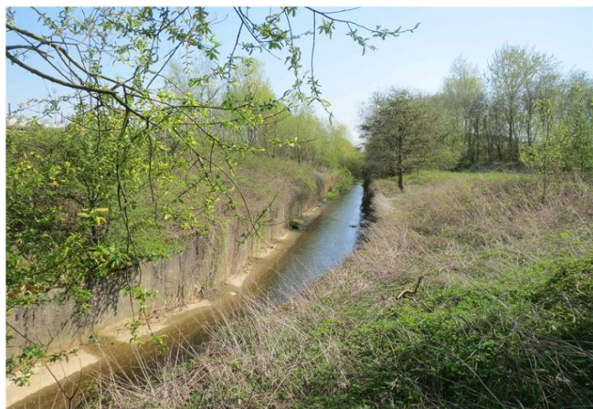
Foto gegen Fließrichtung
