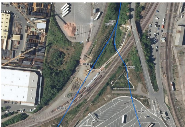
Foto gegen Fließrichtung
