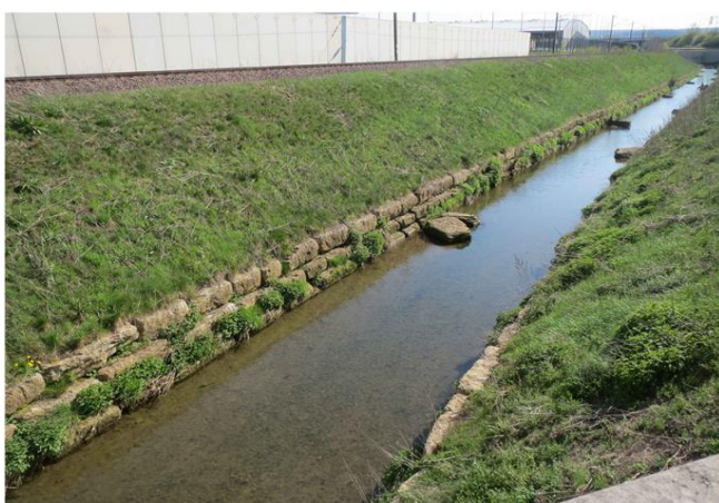
Foto gegen Fließrichtung
