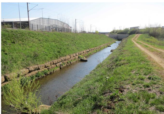
Foto gegen Fließrichtung
