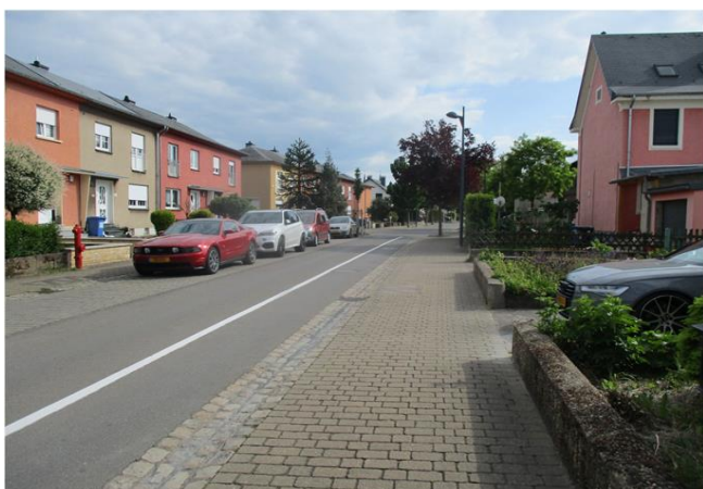
Foto gegen Fließrichtung
