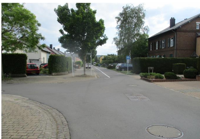
Foto gegen Fließrichtung
