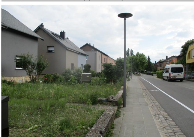
Foto gegen Fließrichtung
