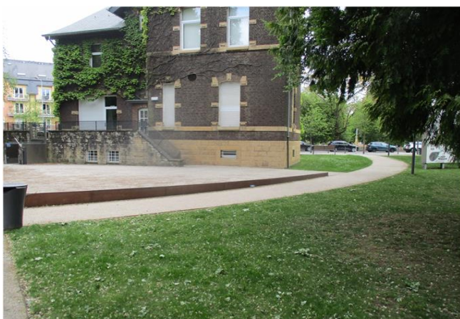
Foto gegen Fließrichtung
