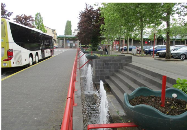
Foto gegen Fließrichtung
