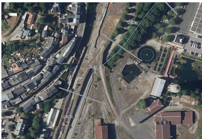
Foto gegen Fließrichtung
