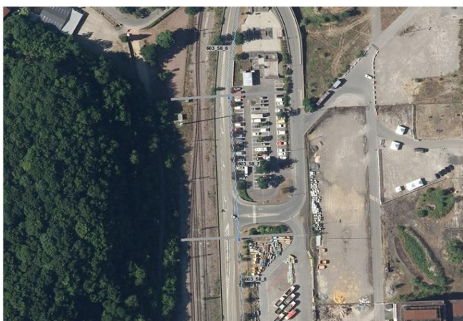
Foto gegen Fließrichtung
