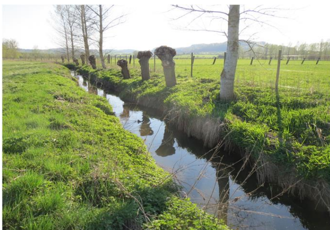
Foto gegen Fließrichtung
