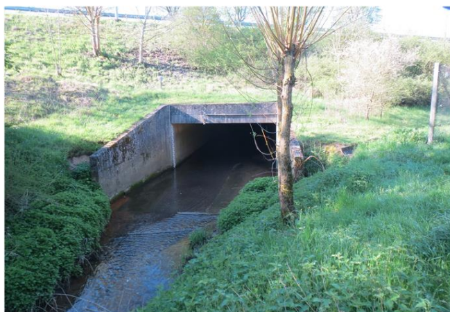
Foto gegen Fließrichtung
