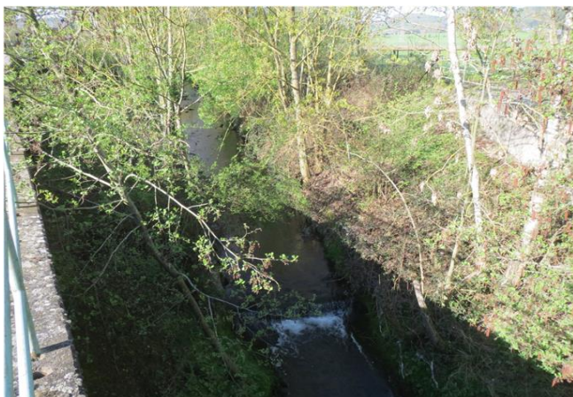
Foto gegen Fließrichtung
