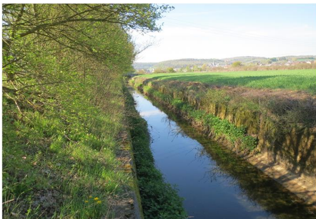
Foto gegen Fließrichtung
