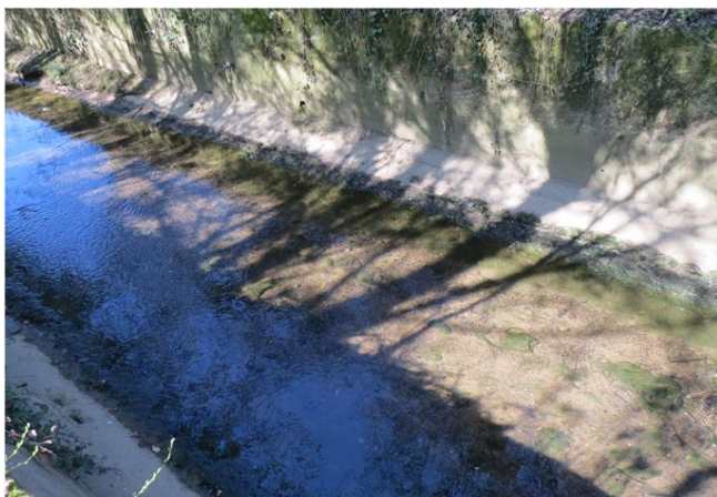
Foto gegen Fließrichtung
