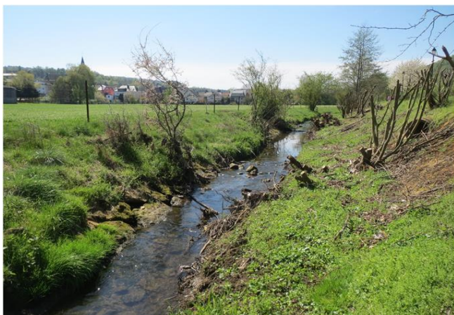
Foto gegen Fließrichtung
