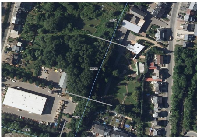
Foto gegen Fließrichtung
