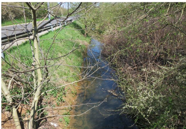
Foto gegen Fließrichtung
