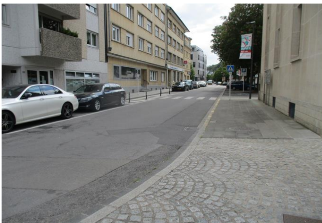
Foto gegen Fließrichtung
