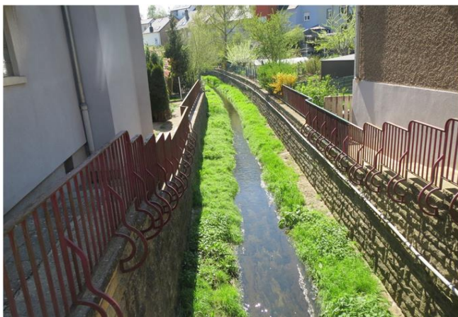
Foto gegen Fließrichtung
