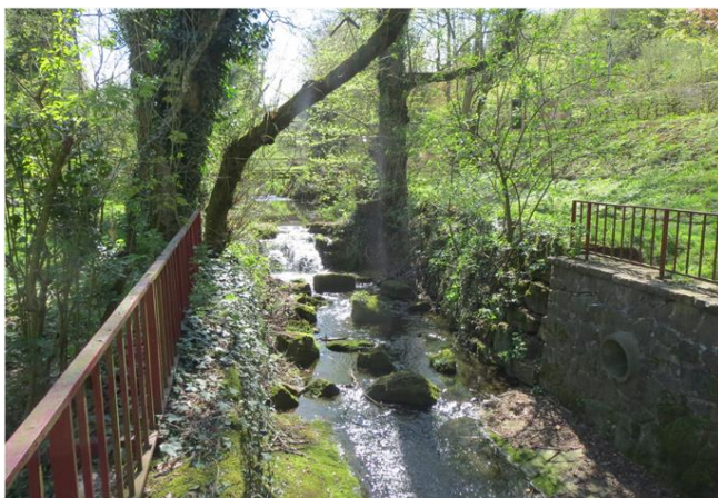
Foto gegen Fließrichtung
