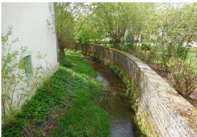
Foto gegen Fließrichtung
