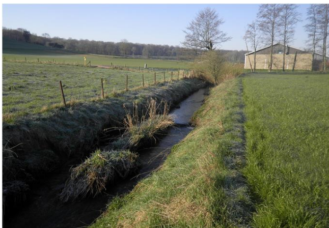
Foto gegen Fließrichtung
