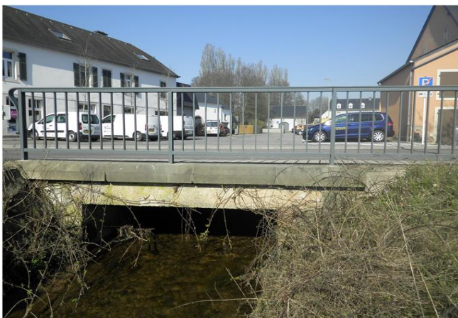
Foto gegen Fließrichtung
