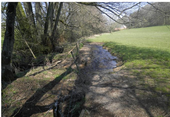
Foto gegen Fließrichtung
