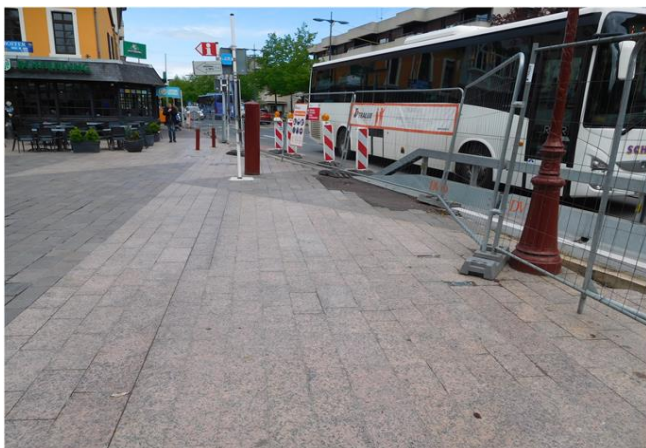
Foto gegen Fließrichtung
