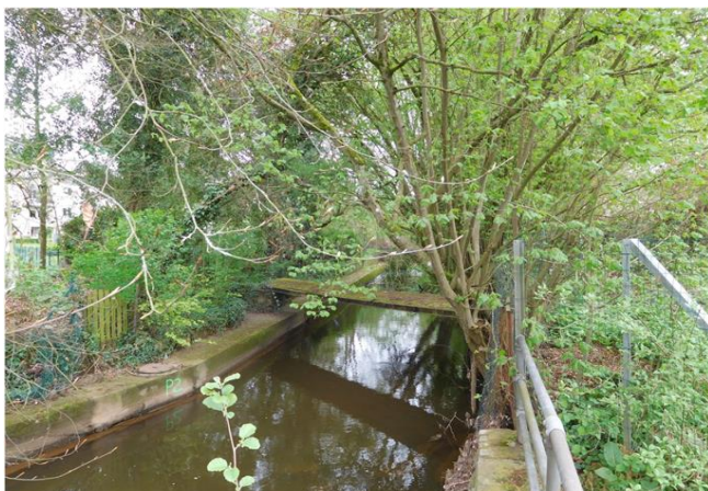
Foto gegen Fließrichtung
