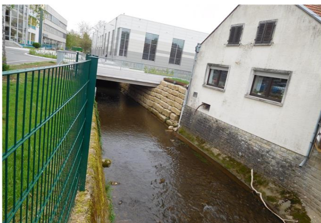
Foto gegen Fließrichtung
