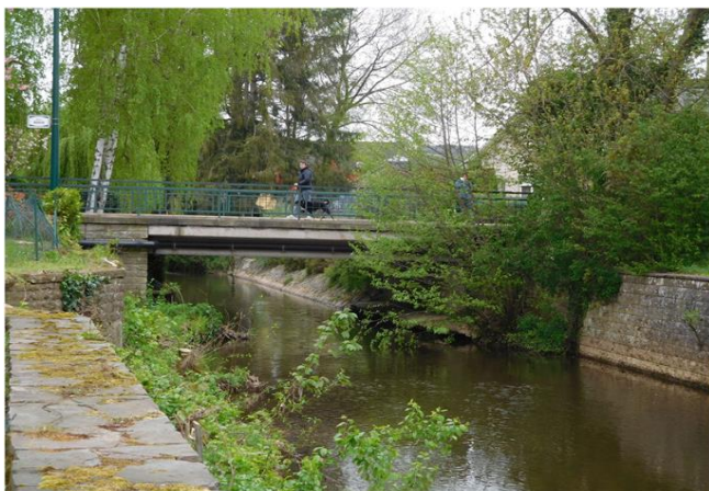
Foto gegen Fließrichtung
