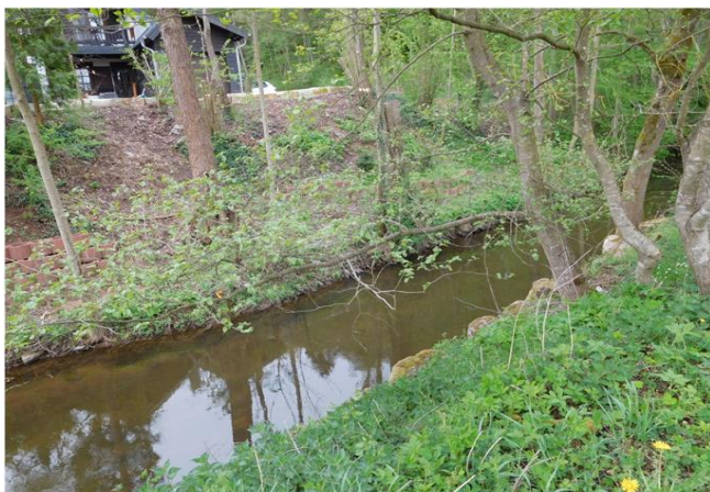
Foto gegen Fließrichtung
