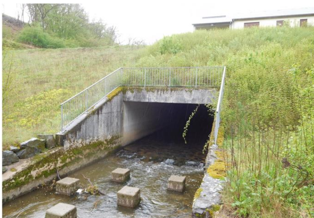
Foto gegen Fließrichtung
