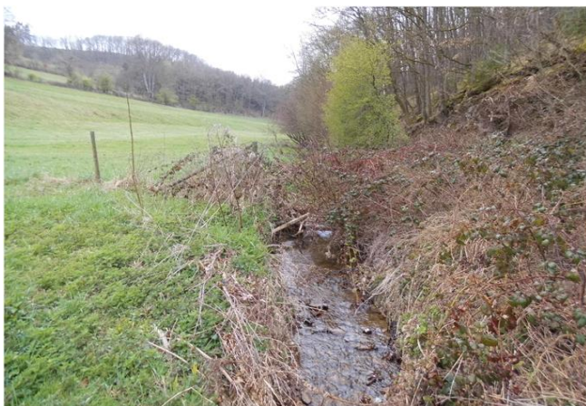
Foto gegen Fließrichtung
