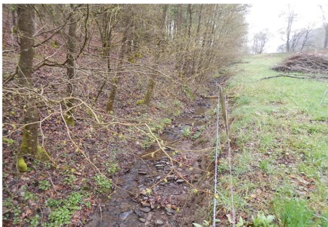
Foto gegen Fließrichtung
