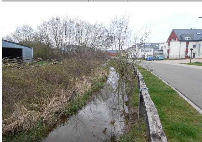
Foto gegen Fließrichtung
