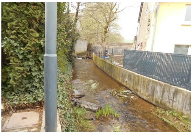
Foto gegen Fließrichtung
