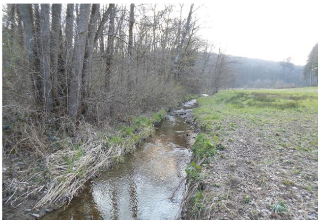
Foto gegen Fließrichtung
