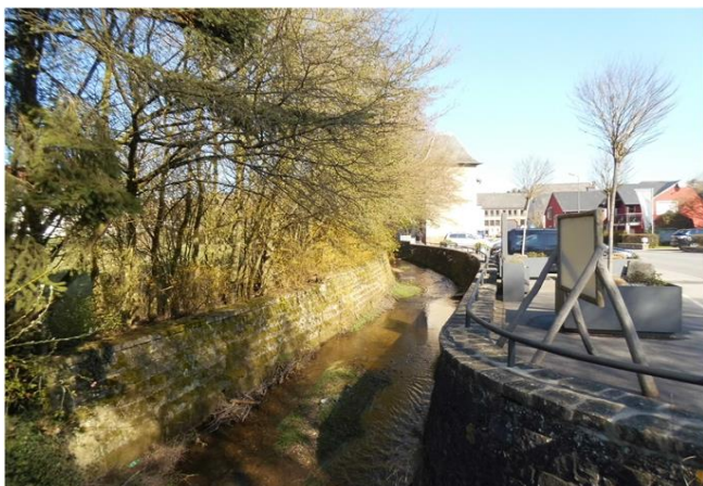
Foto gegen Fließrichtung
