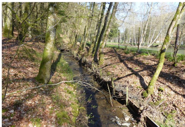
Foto gegen Fließrichtung
