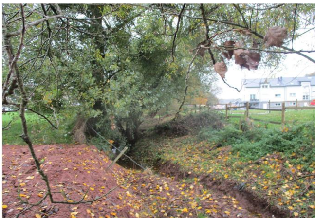
Foto gegen Fließrichtung
