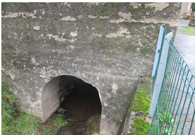
Foto gegen Fließrichtung
