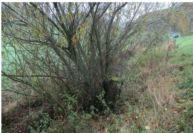
Foto gegen Fließrichtung
