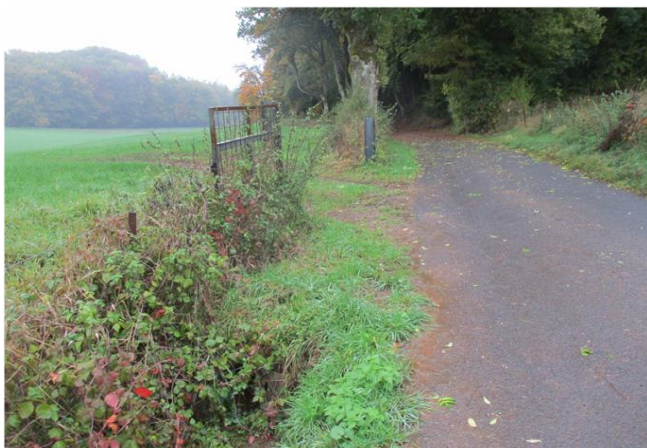
Foto gegen Fließrichtung
